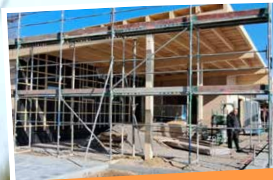
EIN DORF- UND VEREINSHAUS ENTSTEHT
