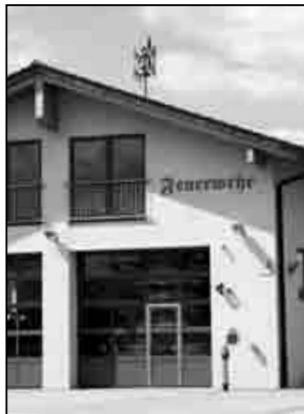
Hier am Dach könnte optional eine neue Sendeantenne der Deutschen Telekom angebracht werden.
