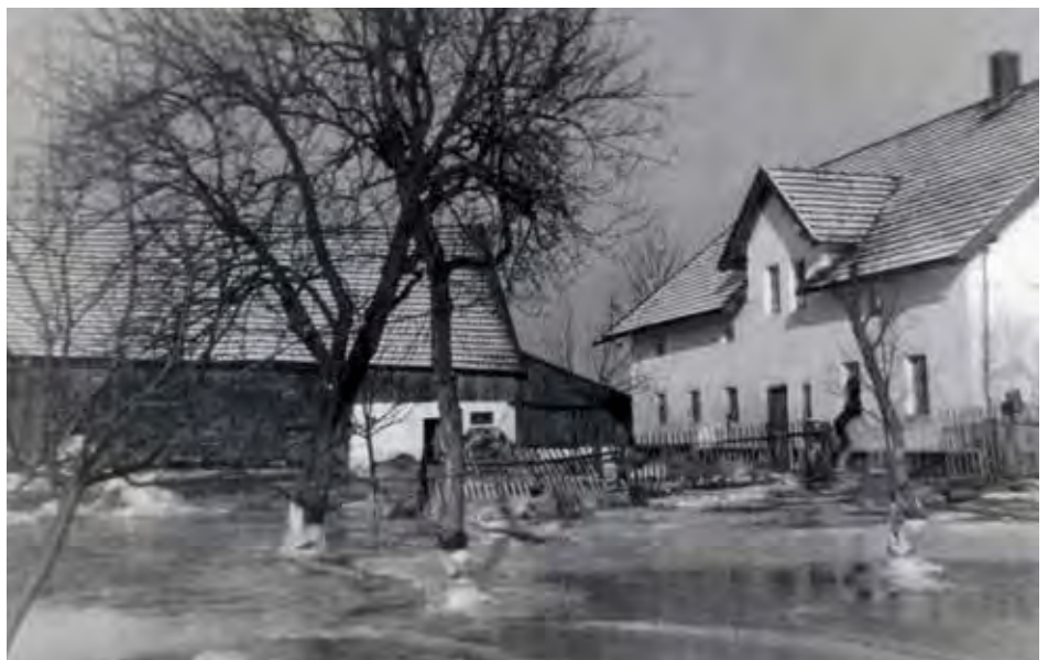
Januar 1941 - Hochwasser Anwesen Rothhammer Niedermotzing
