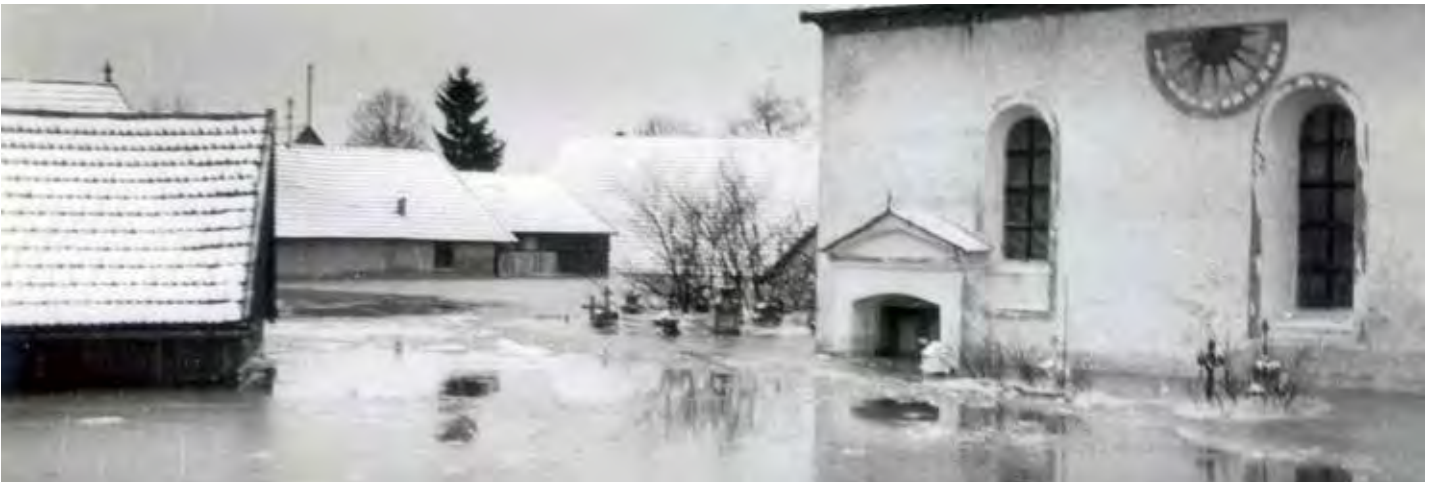
Januar 1941 - Hochwasser bei der Filialkirche St. Georg Obermotzing
