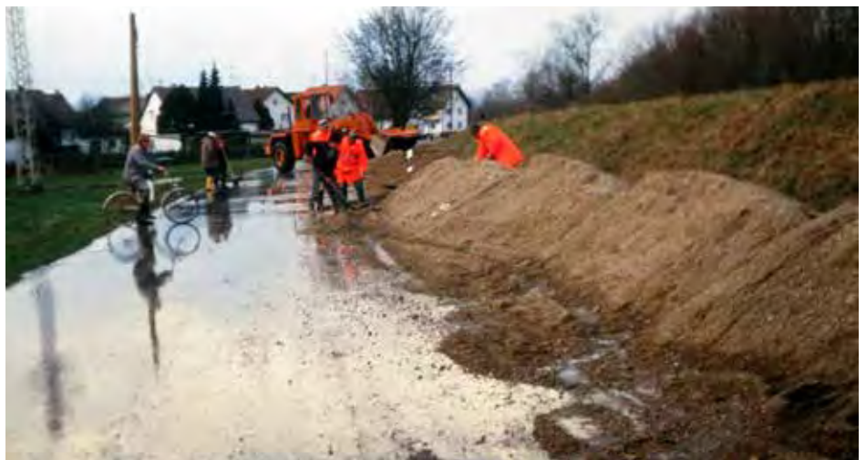
März 1988 - Dammsicherung an der SR10 Ortseingang Niedermotzing
