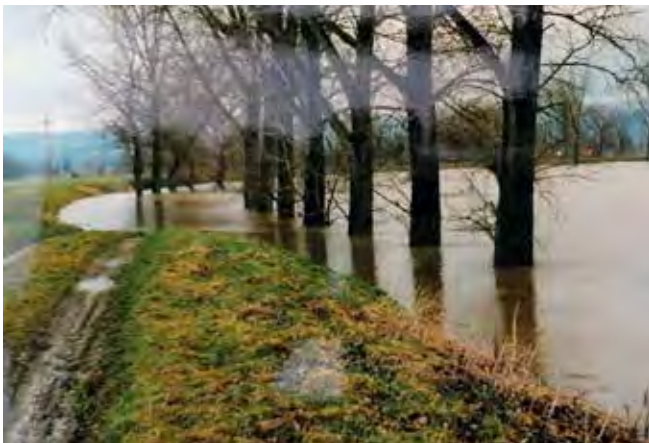
März 1988 - Hochwasser Obermotzinger Au, im Hintergrund das Schöpfwerk an der Bacherei
