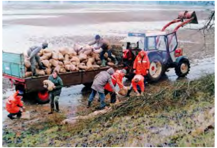
März 1988 - mit Sandsäcken wird der Damm gesichert
